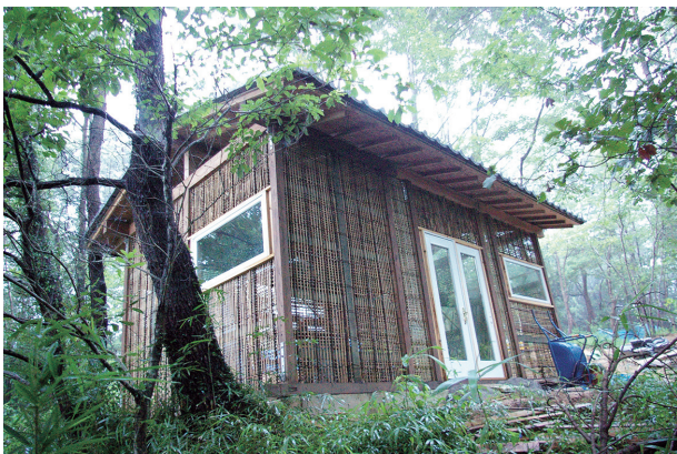
写真1 現場作業小屋で土壁の実践
